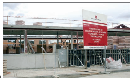
Obras de la Escuela Infantil en el Recinto Ferial
